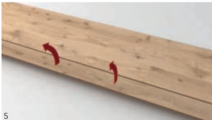
5 Zur Demontage wird die verriegelte Reihe angehoben und ausgehebelt.
