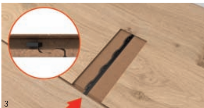
Erst mit dem Verlegen der nächsten Reihe wird die Feder aktiviert.
