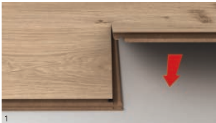
Der Boden wird kopfseitig dicht an der nebenliegenden Diele abgesenkt.
