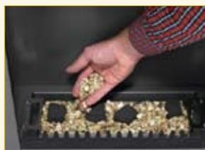
Nachdem die Kohlestückimitate positioniert wurden, kann das Vermiculitgranulat eingestreut werden
