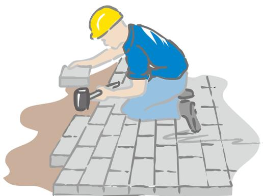
Eine homogene Farbverteilung erzielt man, indem die Steine beim Verlegevorgang scheiben- und nicht lagenweise aus mehreren Paketen gleichzeitig entnommen werden. Dies gilt insbesondere bei nuancierten Pflastern, ist aber auch bei einfarbigen oder grauen Pflastersteinen hilfreich, um ein natürliches Aussehen zu erzielen.
