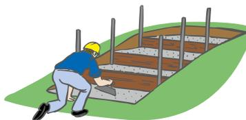
Wenn die Form ausgehärtet ist, die Schalung wieder entfernen. Auf die vorgeformten Stufen 2 – 3 Querstreifen aus Mörtel (1 – 2 cm dick, der Mörtelgruppe MG III) zur Verklebung der Stufe auftragen.
