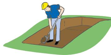
Trag- und Frostschutzschicht aus frostsicherem, kornabgestuftem Material (z. B. Kies oder Schotter) einbringen und verdichten. Diese Schicht sollte ca. 20 – 30 cm stark sein.
