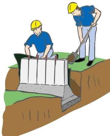
Aus optischen Gründen empfiehlt es sich, Rundpalisaden mit der Kehlung zur jeweils höheren Palisade auszurichten. Palisaden mit rückseitiger Erdanfüllung sollten zum Schutz vor Feuchtigkeit mit einer geeigneten Folie abgedichtet werden. Die Hinterfüllung erfolgt mit frostsicherem Material (Kies, Lava), das lagenweise verdichtet wird. Ist der Untergrund nicht ausreichend sickerfähig oder Hangwasser zu erwarten, muss eine Drainage vorgesehen werden.
